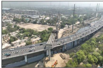
जगहों पर पिलर्स के बीच की दूरी को आवश्यकतानुसार बढ़ाया जाता है और ऐसे क्षेत्रों में वायडकट निर्माण हेतु पिलर्स को जोड़ने के लिए स्पेशल स्पैन का उपयोग किया जाता है। उन्होंने बताया कि इस लोकेशन पर भूतल पर
